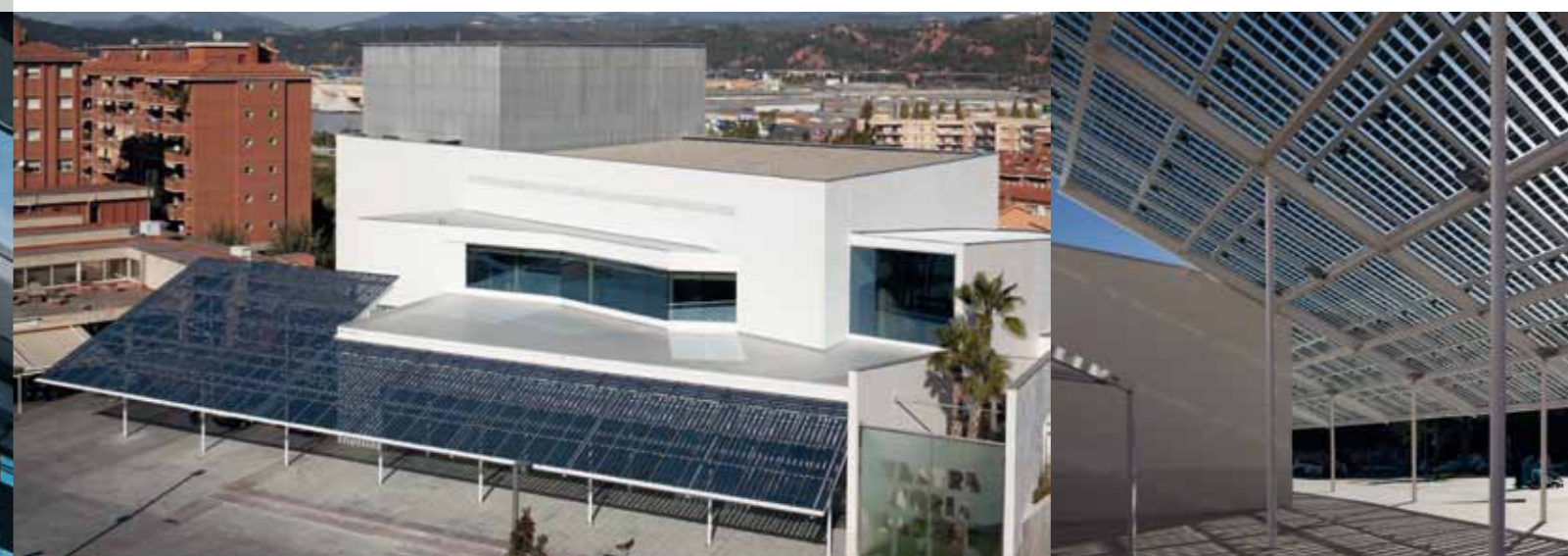
Curtain wall roof application with photovoltaic panels - Teatro Municipal Nuria Espert - Sant Andreu de la Barca, Spain (Architect : EPG Estudios y Proyectos Grau SL)
