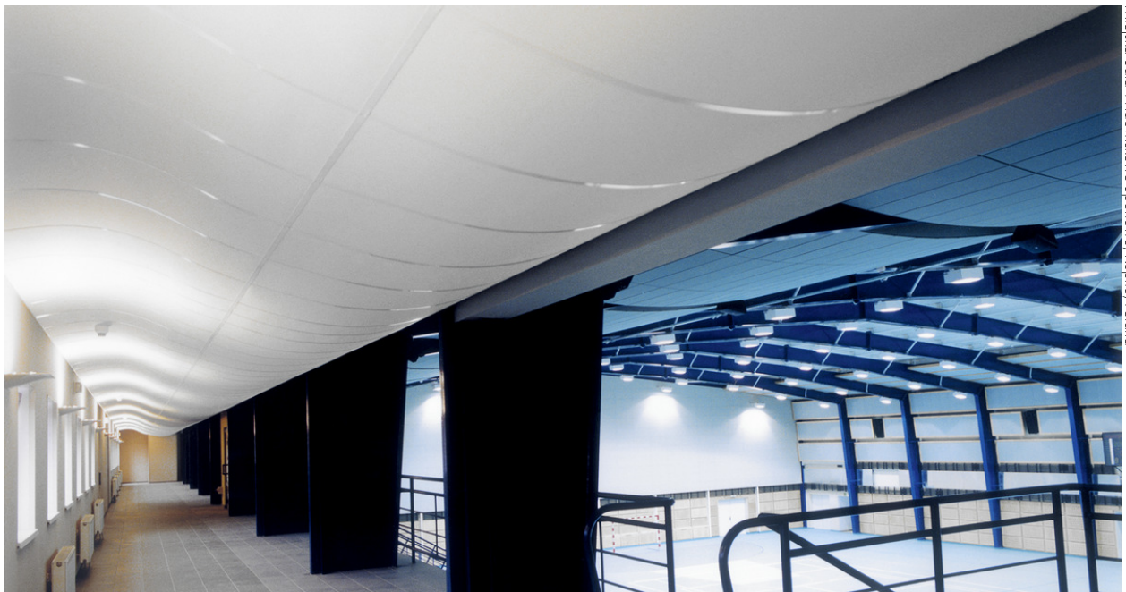
Miejska Sala Widowiskowo-Sportowa, Kępno, Poland
