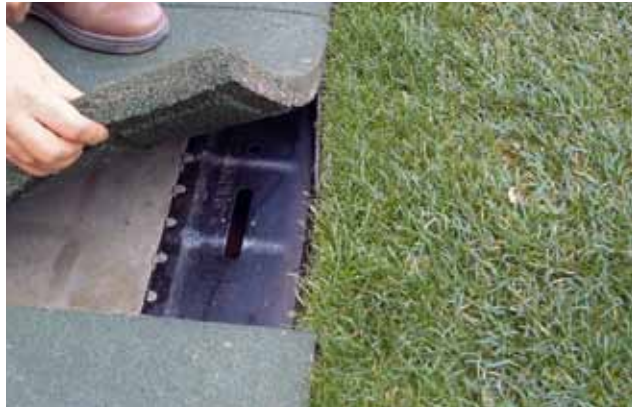
SPORTFIX slotted channel in the Estádio da Luz
